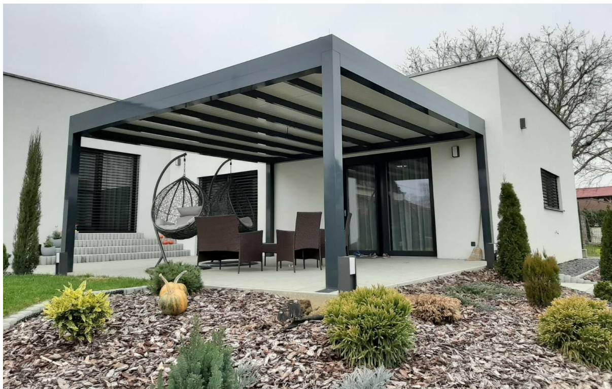
Výstavba a montáž pergoly.
