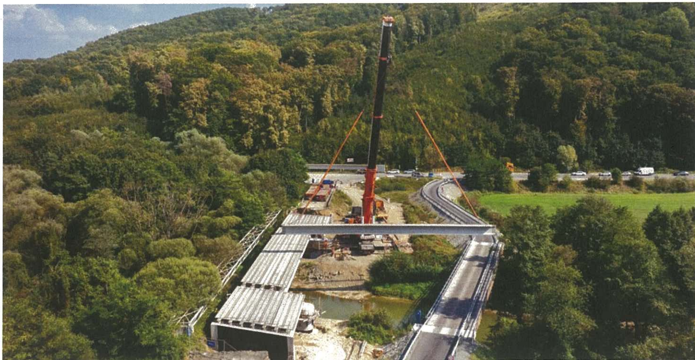
Pokládka nosníkov na moste cez rieku Ondava v obci Miňovce
