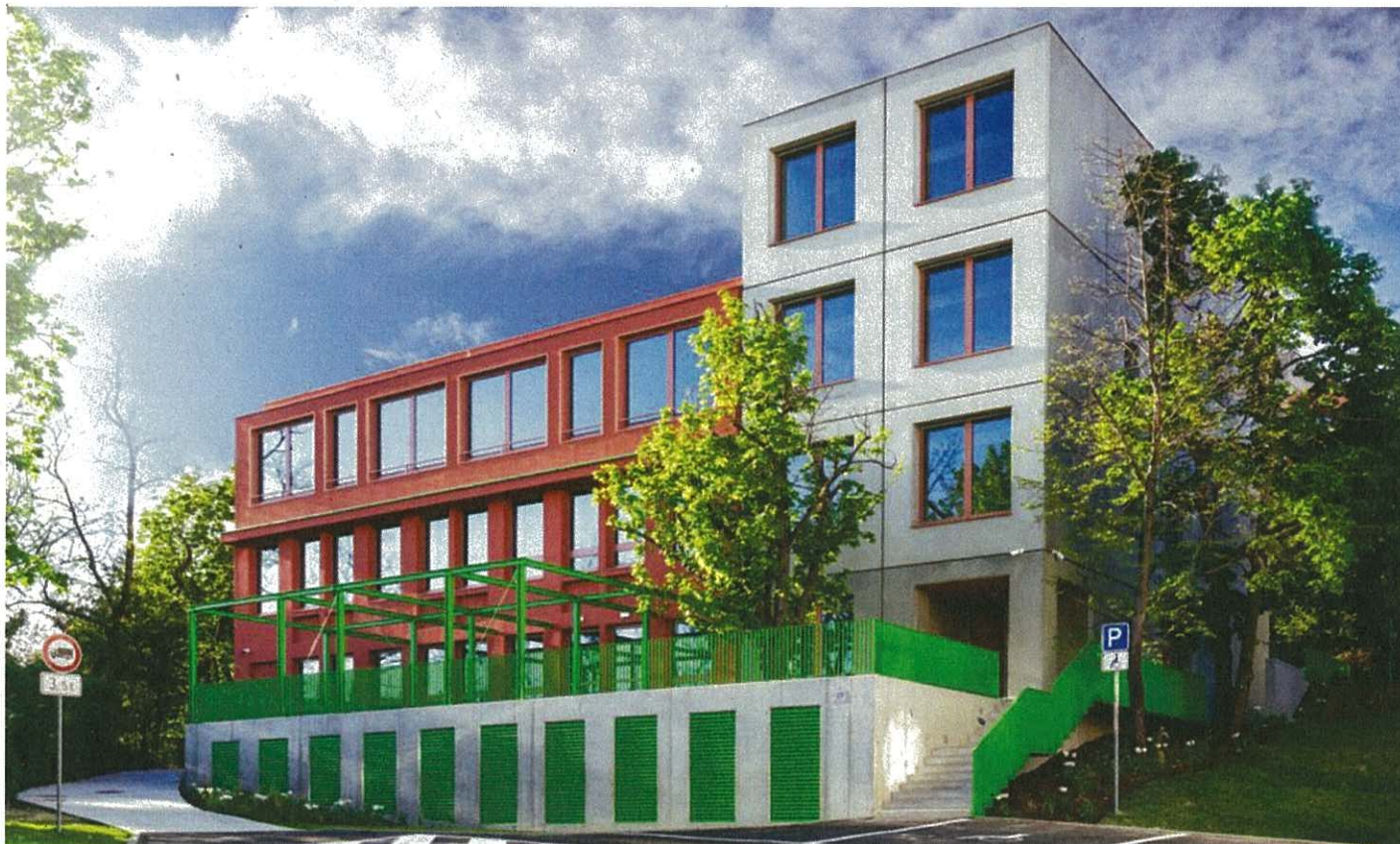
Rekonštrukcia ZŠ a MŠ Čádrova
