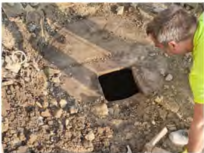
Súkromný zákazník, oprava kanalizácie – nové kanalizačné rozvody – rodinný dom – Cintorínska ulica, (2023)
