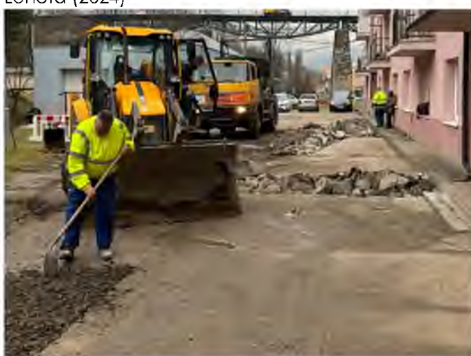
Mesto Handlová, oprava nádvorja, Prievidzská ulica (2024)
