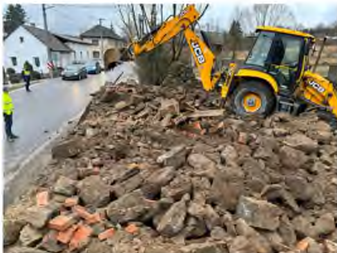
Súkromný zákazník, demolácia starého domu, Nová Lehota (2024)
