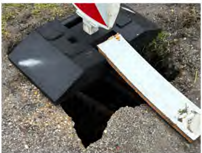
Mesto Handlová, oprava kanalizácie, Nová Lehota (2024)
