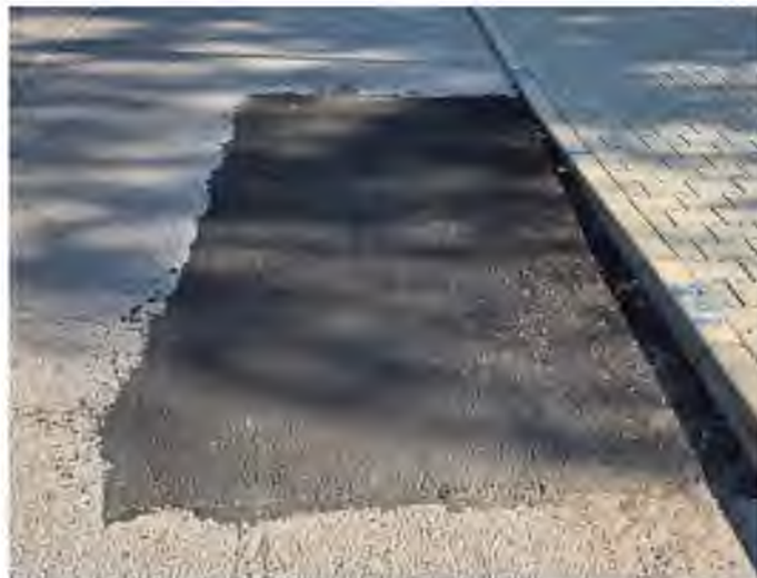
Mesto Handlová, oprava výtlkov, Partizánska, Handlová
