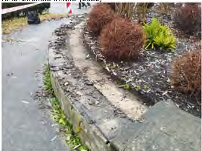
Mesto Handlová, Rekonštrukcia bývalej fontány – Mierové námestie (2023)
