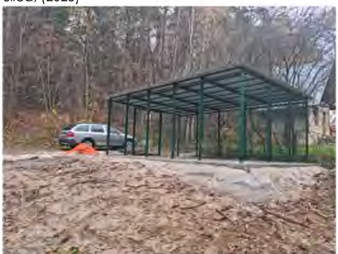
Obec Lazany, výstavba stojiska na odpad (2022)
