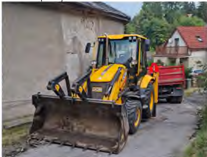
Mesto Handlová, Rekonštrukcia cesty – Nová Lehota, zjazd z hlavnej cesty I/9 (2023)
