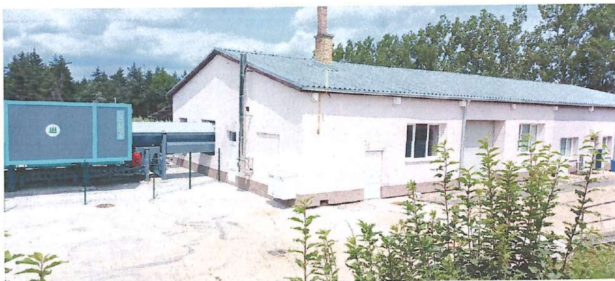
Národné lesnícke centrum – po vykonaní stavebných úprav
