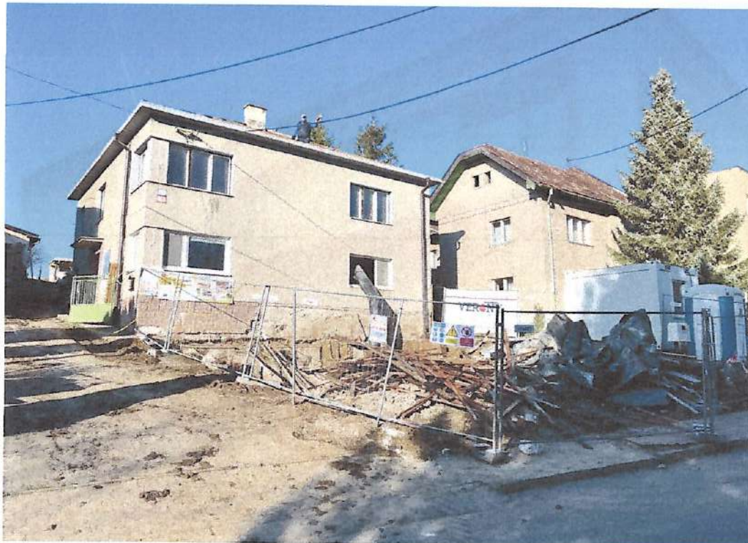
Obec Selce – na začiatku prestavby
