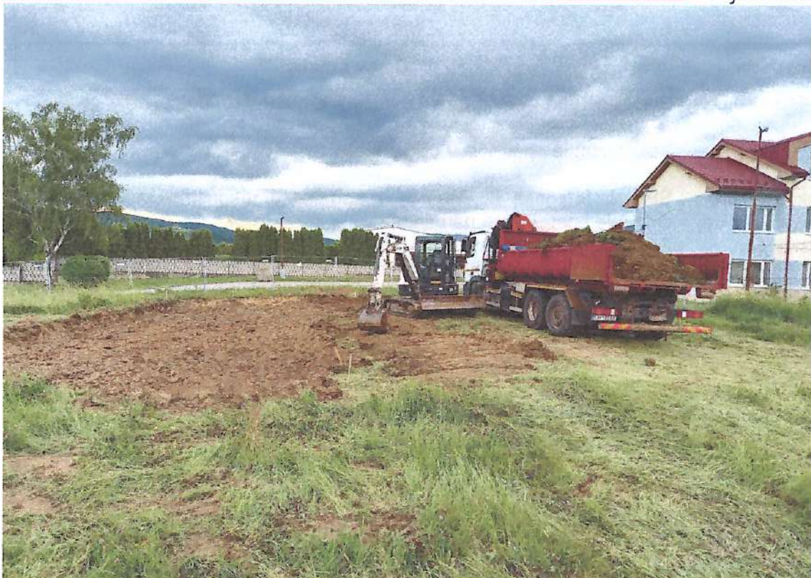
Bytový dom blok B 2-4 Krupina – začiatok stavby
