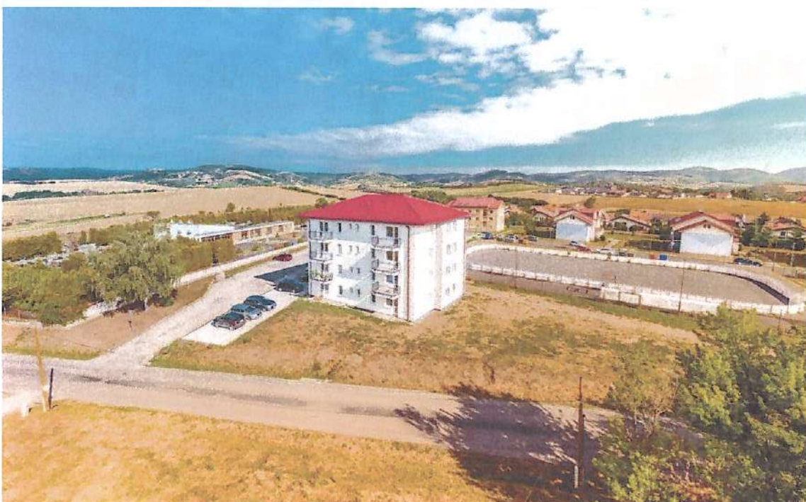
Bytový dom blok B 2-4 Krupina – hotové dielo
