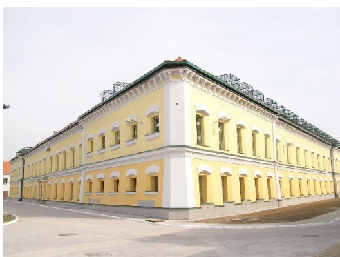
Cena Zväzu stavebných podnikateľov Slovenska - Väznica v Leopoldove - rekonštrukcia národnej kultúrnej pamiatky zo 17. storočia v 11. ročníku súťaže STAVBA ROKA 2005 za Rekonštrukciu objektu č.20 (Hrad) v Nápravno-výchovnom ústave a Ústave na výkon trestu odňatia slobody Leopoldov
