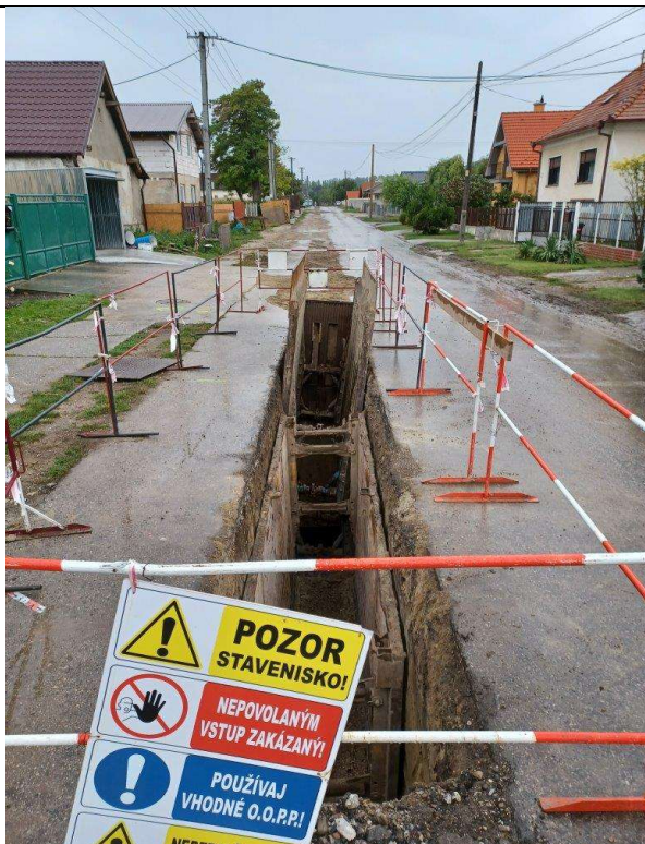
Kanalizácia Lúč na Ostrove
