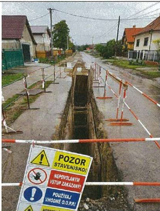
Kanalizácia Lúč na Ostrove
