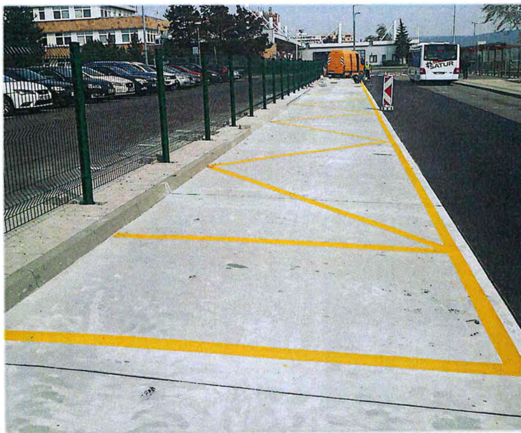
Devínska Nová Ves – kompletne zhotovenie spevnených plôch
