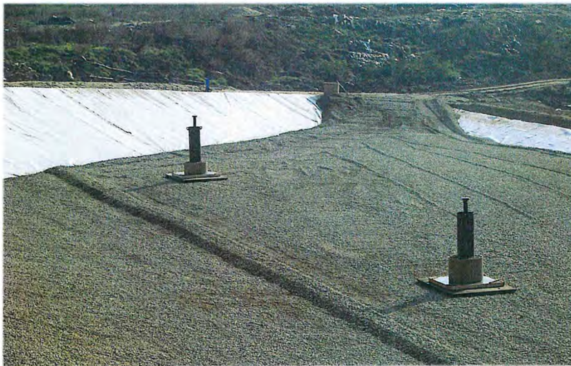
BOJNÁ – skládka odpadov, časť C – 2. Etapa
