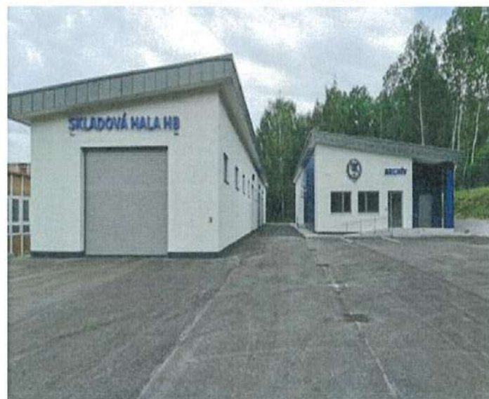
VÝSTAVBA BUDOVY ARCHÍVU A SKLADOVEJ HALY ŽILINSKEJ UNIVERZITY V ŽILINE
