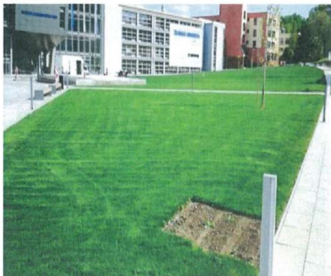
STAVEBNÉ ÚPRAVY EXISTUJÚCICH PŬCH A BUDOVANIE PRVKOV ZELENEJ INFRAŠTRUKTÚRY ŽILINSKEJ UNIVERZITY
