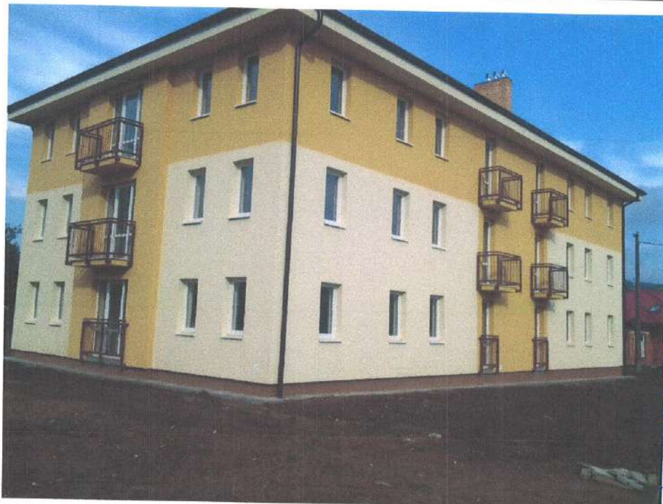
Bytový dom 12 b.j. Bystré
