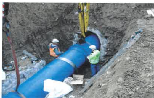
Obr.č.18-21- Oprava prírodného potrubia Nitrianske Rudno-bezvýkopová metóda (montáž potrubia v svahovanej jame)
