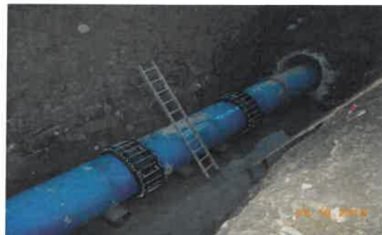
Obr.č.18-21- Oprava prírodného potrubia Nitrianske Rudno-bezvýkopová metóda (montáž potrubia v svahovanej jame)
