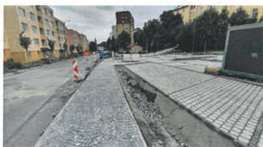
Obr.č.11-15- Realizácia- kanalizácie; ČOV, vybudovanie parkoviska
