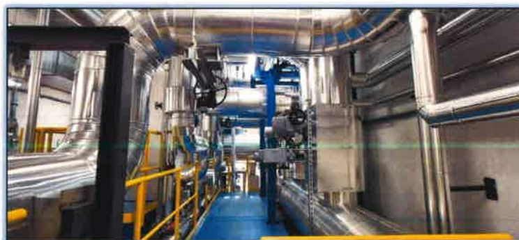
2023 KOSIT Košice kotel K1 rekonštrukcia
