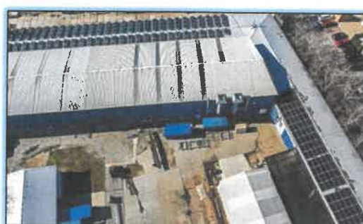
Slnéčné kolektory a vykurovanie
