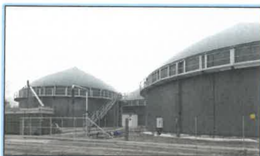
Stavba bioplynová stanica
