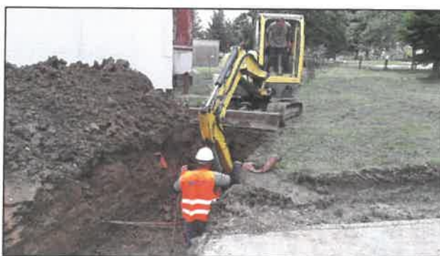
Stavba TEHO Košice rozvody
