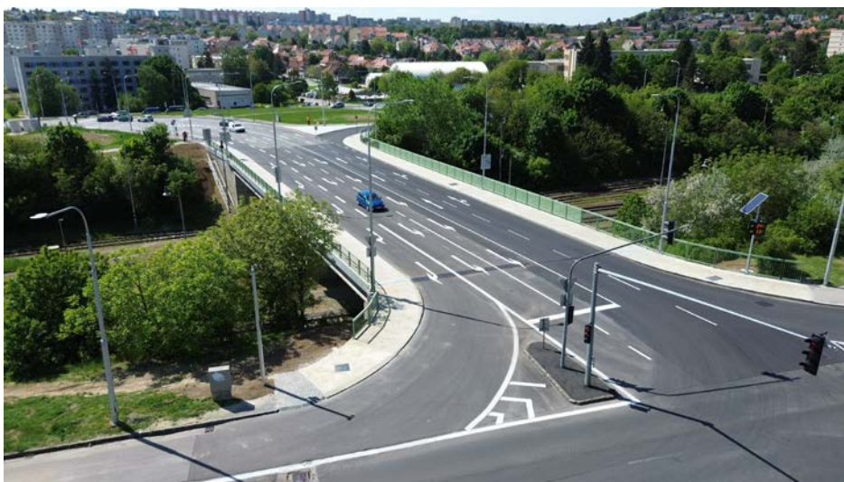
📷 Rekonštrukcia mosta, Nitra
