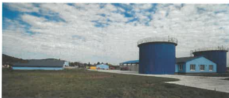
Kráľovský Chlmec - kanalizácia a ČOV
