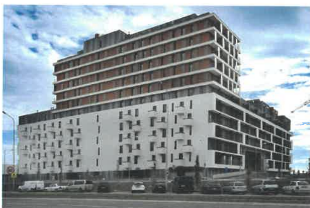
Južné mesto - Bytový dom AI
