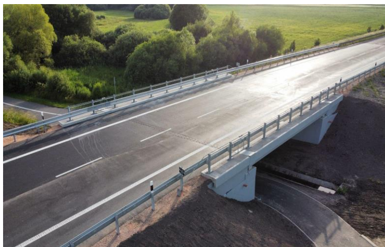
Rekonštrukcia mosta ev. č. I/18 – 389 A Poprad (Direkcia TG)
