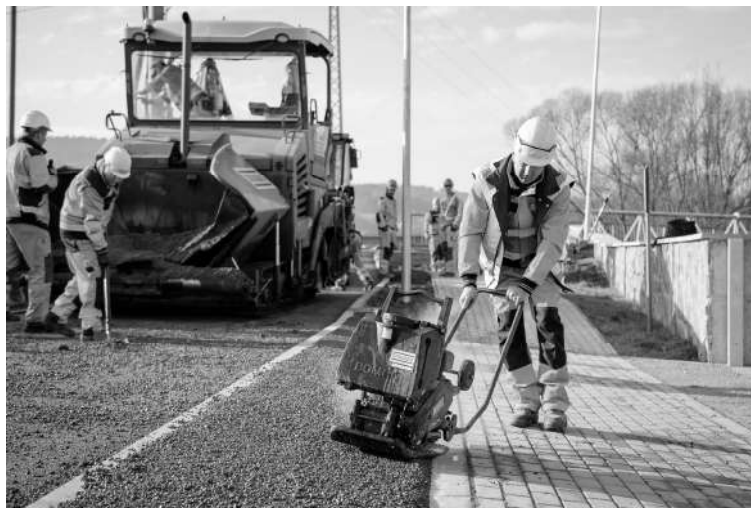
Pokladanie a zhutňovanie asfaltu, Cyklochodník Bardejov
