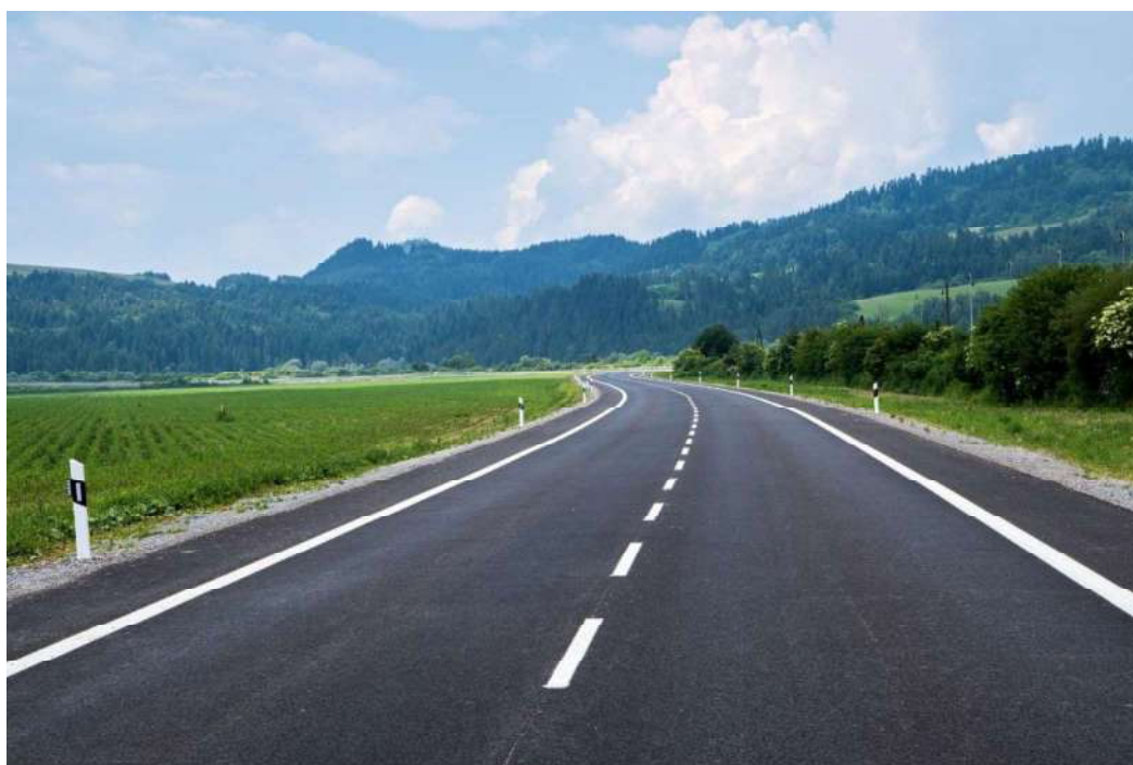
stavba: I/68 Plavnica, preložka cesty
